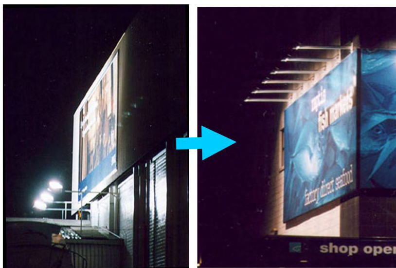
圖2-1.6 廣告投光應改為向下投光以防止天空輝光
