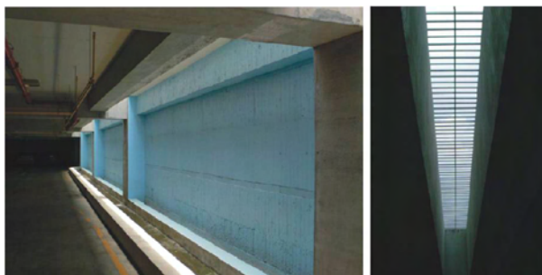
【地下室採光通風天溝設計示意圖】
